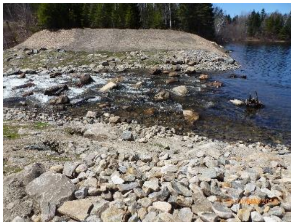
Figure SEQ Figure \* ARABIC 4 : Barrage du lac Lachance, Saint-Damien - 2016 (MELCCFP, Répertoire des barrages)
